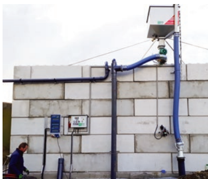
Der Separator wurde auf diesem Kuhbetrieb auf einer Betonwand befestigt, um die Feststoffe darunter zu sammeln. The separator is installed on a concrete wall on a cow farm to collect the dry material below.
