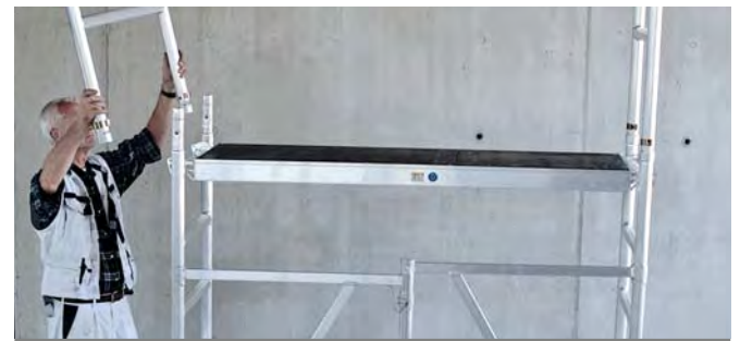
Schritt 5: Geländerrahmen aufstecken
