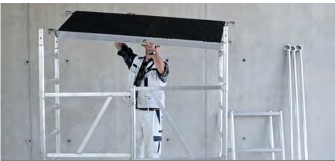
Schritt 4: Plattform einhängen
