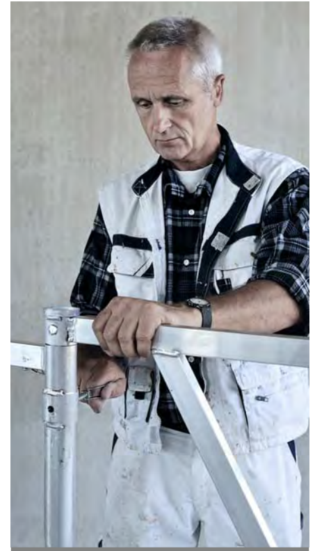
Schritt 3: Klapprahmen mit Splint fixieren
