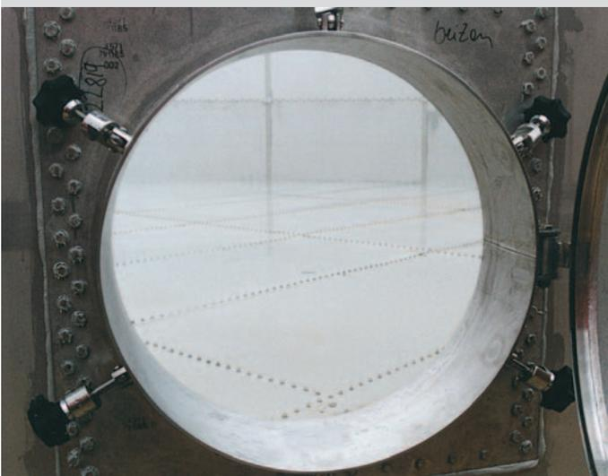
Der Edelstahlboden ist zusammen mit dem umlaufenden Winkel auf der Betonplatte mit Edelstahlschrauben und Edelstahldübeln befestigt.
